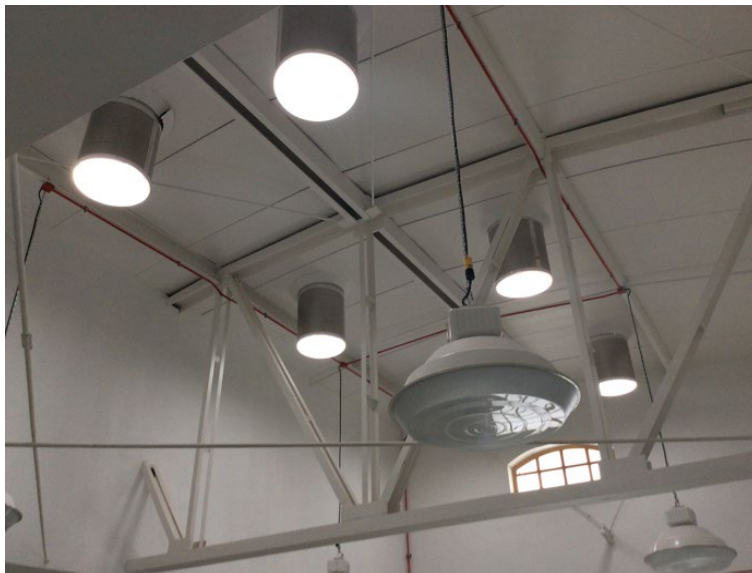
Fig. 14. Tubos solares que permiten la captación de luz natural dentro del laboratorio.
